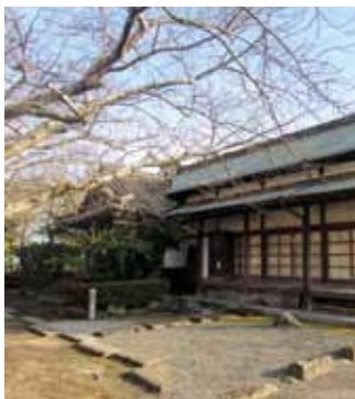
佐伯城三の丸御殿の玄関・広間部分を解体し、船頭町に移築。
